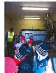
Visite de la chaufferie
